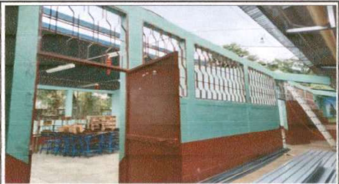
Foto 4: MODULO 2 AULAS Sustitución de lámina, por lamina troquelada aluzinc calibre 26
