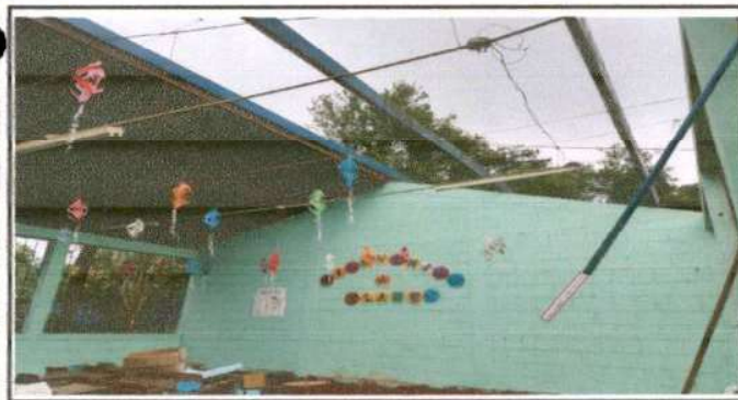
Foto 5: MODULO 2 AULAS Sustitución de capote de lámina para lámina troquelada
