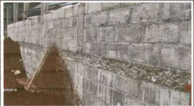
Foto 2: MODULO 1 MURO Reparación de muro perimetral de block con soleras intermedias y columnas
