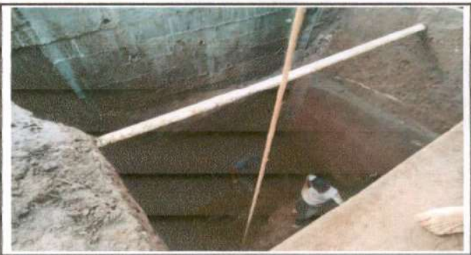
Foto 6: Sustitución de fosa séptica
